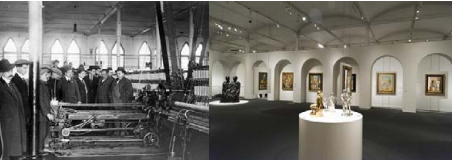
Figura 2. Antigua Fábrica de Hilados Casarramona, Barcelona. Fuente Internet
